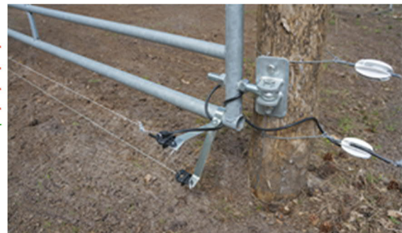
Bild 13 – Tor mit zusätzlicher Elektrifizierung als Schutz vor Untergraben bzw. Überklettern (Grafik: G. Herkert, Bild: F. Faß)
