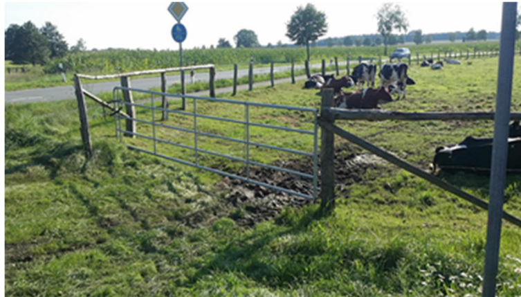
Bild 12 – Tiefe Fahrspuren unter dem Tor sind eine Schwachstelle (Bild: F. Faß)
